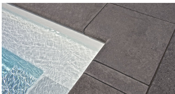
Zwembadomranding met Oud Hollandse betonstructuur (1)
