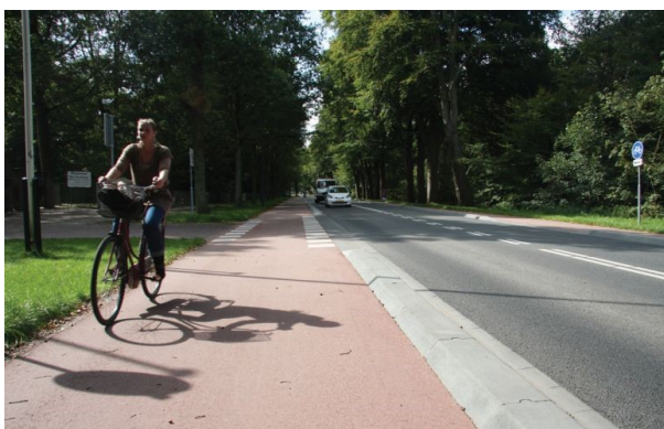
Scheiding van fietspad en rijbaan
