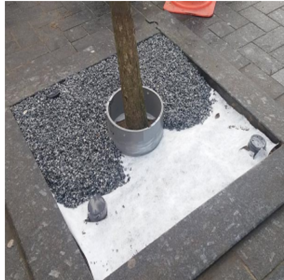
Stap 2 - Homogeen bindmiddel A en B mixen met schoon en droog grind
