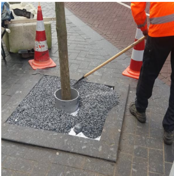
Stap 3 - Pas een meegroeiring toe en de juiste laagdikte
