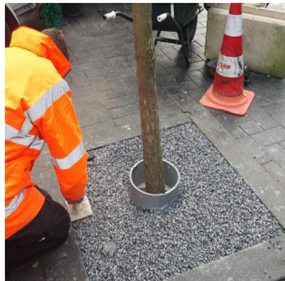
Stap 4 - Egaliseren met een rei of gelijkwaardig
