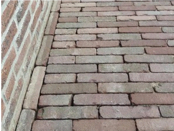
Stap 1 - Stabiele, schone ondergrond en voeg
