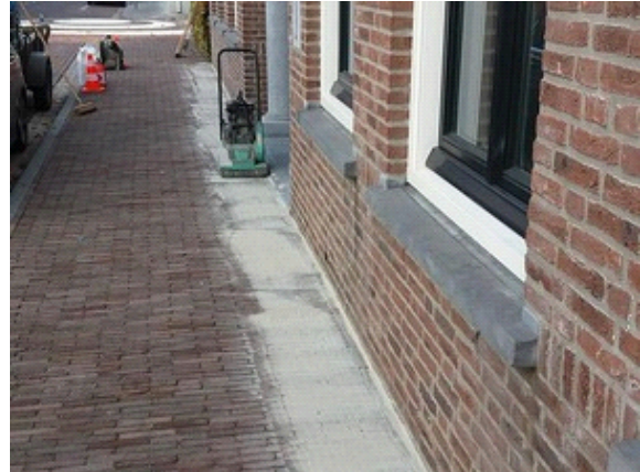
Stap 2 - Kant en klaar mengsel verdelen en intrillen (proces herhalen)
