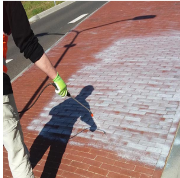
Stap 2 - City-Slim aanbrengen tot de voegen en het oppervlak volledig verzadigd zijn
