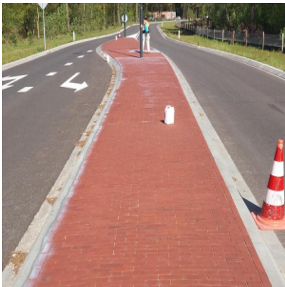
Stap 3 - Verwijder overtollig product met trekker
