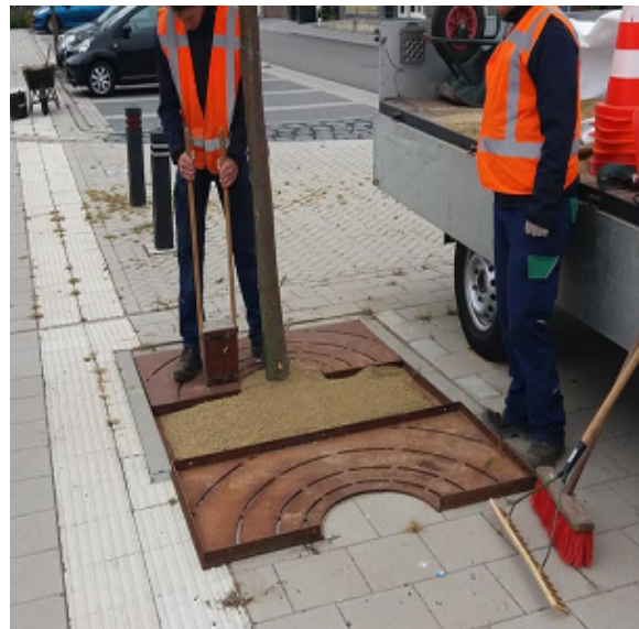
Stap 3 - Toepassen van stalen boomroosters indien gewenst
