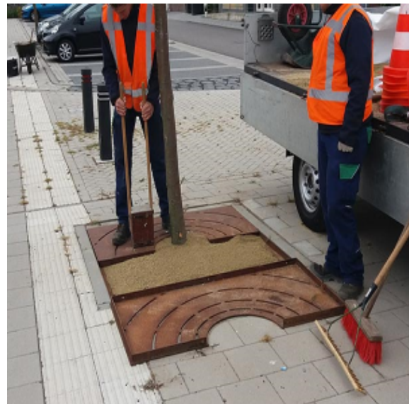
Stap 3 - Toepassen van stalen boomroosters indien gewenst
