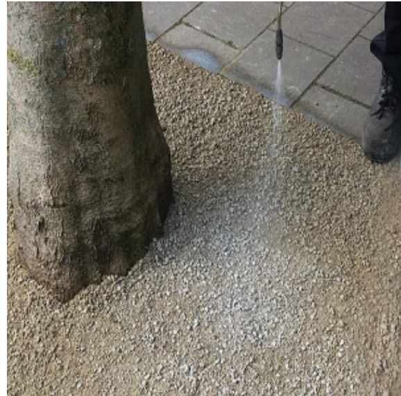
Stap 2 - Aanbrengen van de CitySlim coating
