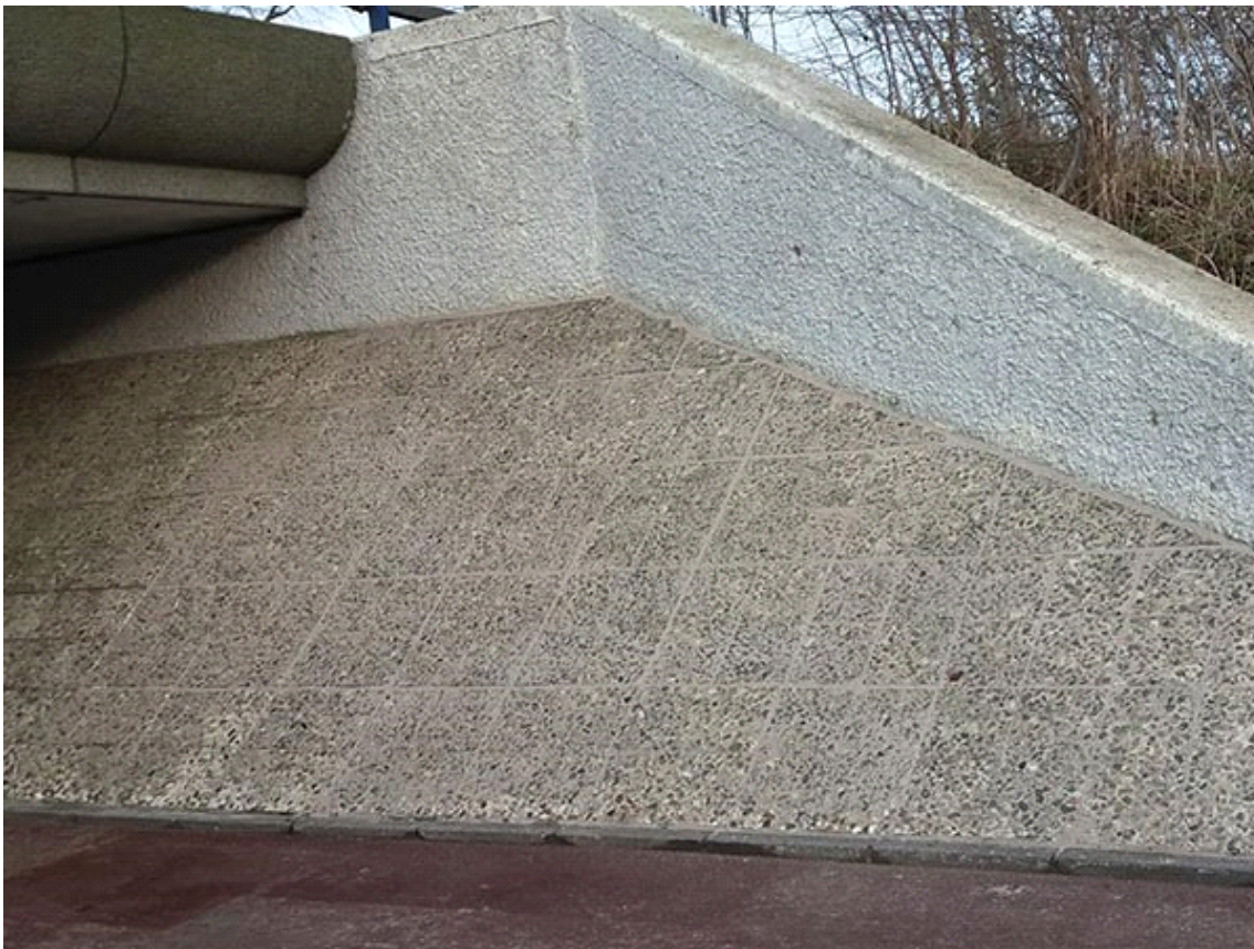
Vastleggen van tegels in taluds met PVN Epoxyvoeg
